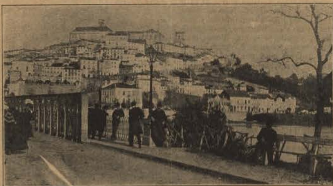
COIMBRA—VISTA DA PONTE DO MONDEGO
