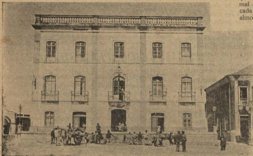
LAGOS—EDIFÍCIO DA CAMARA
