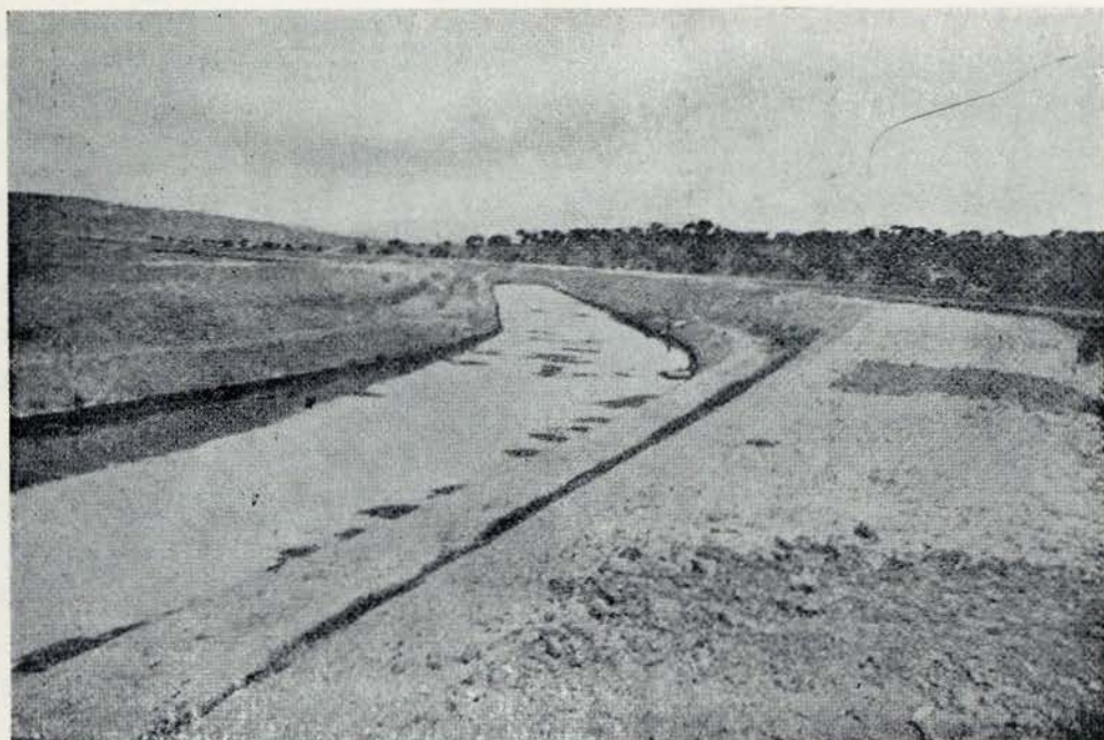
BENAGAZIL — Um trôço do rio Sado, regularizado
