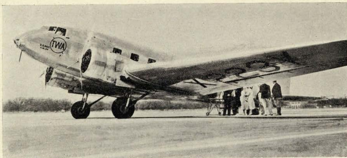
Tipo moderno de avião empregado nas linhas da América do Norte Número de passageiros, 14—Velocidade máxima, 340 Km. à hora—Raio de acção 1.000 Km.
