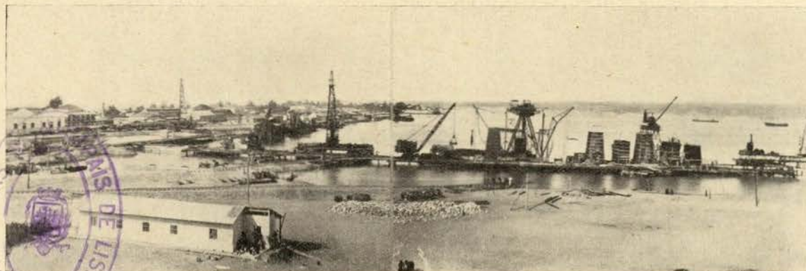
Novo Cais em construção no Pôrto de Lobito
