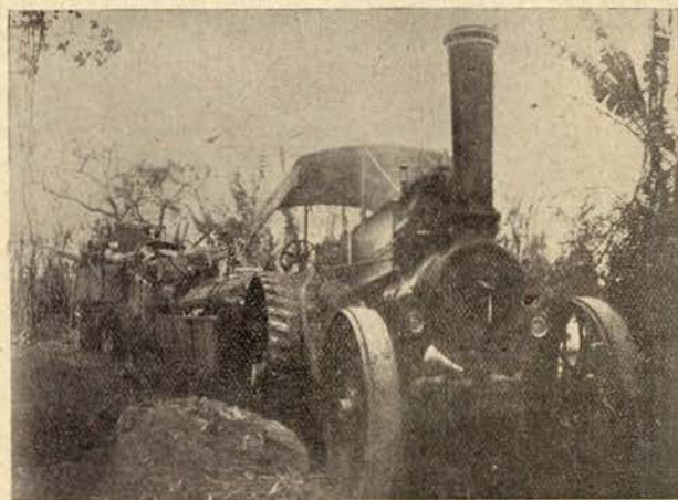
A primeira experiência de tracção mecânica em Angola (1901). Locomotiva Fowko em marcha, rebocando 2 vagons carregados na passagem da ribeira Colombo (caminho Lucala-Malange)
