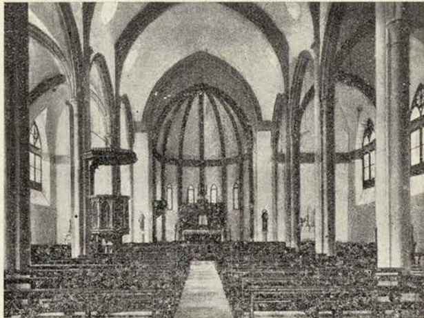
Intérieur de l'Eglise de la Mission de Beira (Mozambique)
