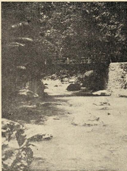
TIMOR — PONTE SOBRE A RIBEIRA DE SAME
