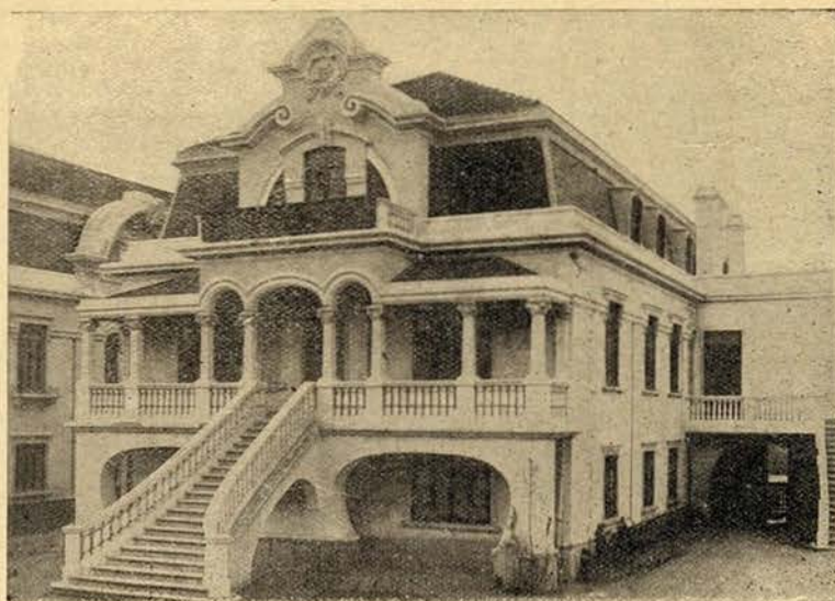
Um dos edificios onde está instalado o Colégio
