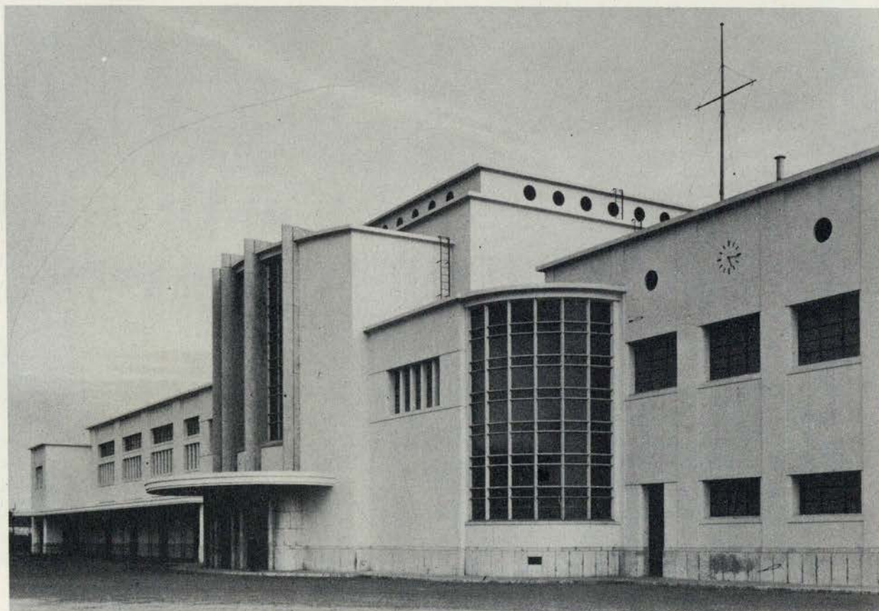
A fachada principal da Gare Marítima
