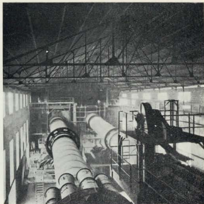
Fornos de fabricação do cimento
