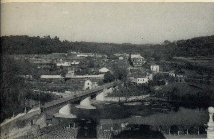
Ponte do Ave, vista de Alem do Rio
