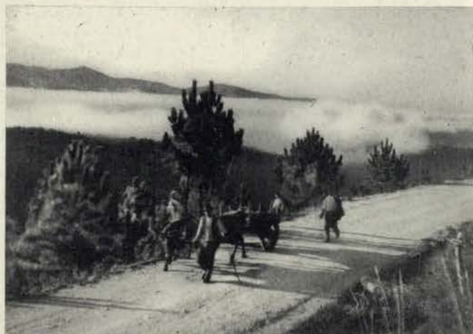
Trecho de estrada em Sever-do-Vouga
