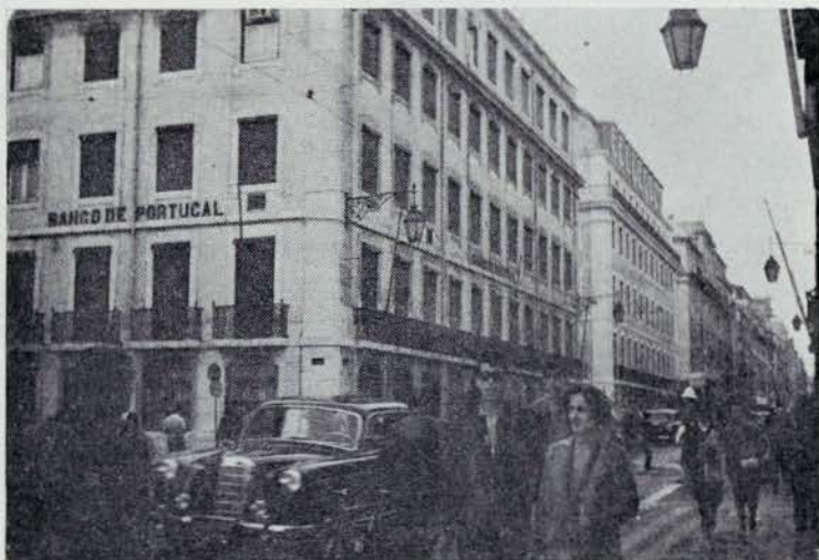
Fig. 9 — Rua Nova (actualmente confluência das Ruas do Ouro e do Comércio)
