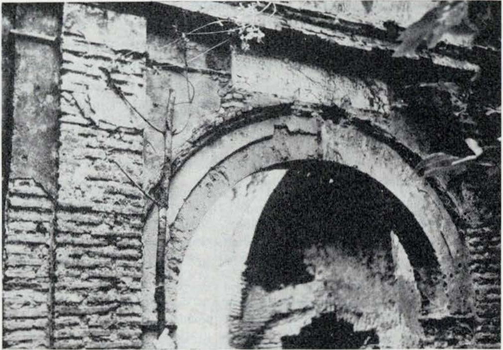
Um dos poços da antiga galeria de 1782
