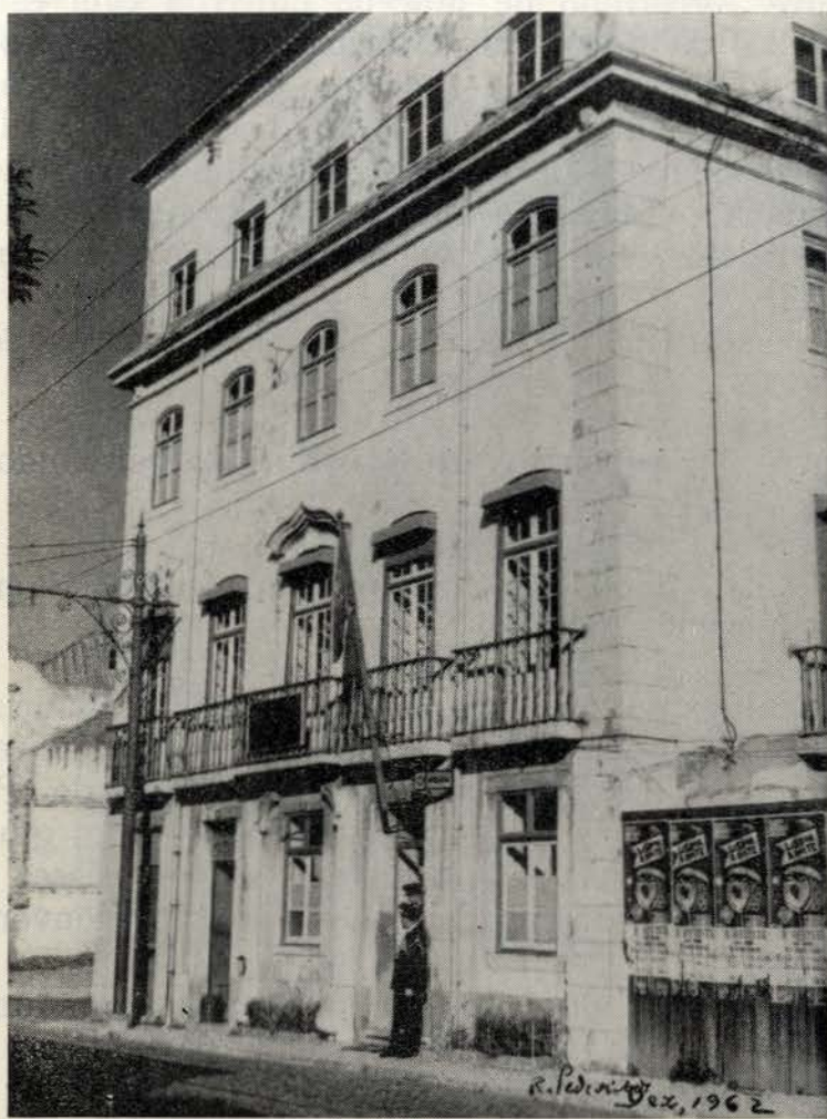
O prédio da Rua de Pedrouços n.º 97, onde morreu o P.º José Agostinho de Macedo
