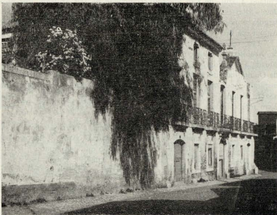
Estado actual do palácio da Quinta da Vitória, em Sacavém de Cima
