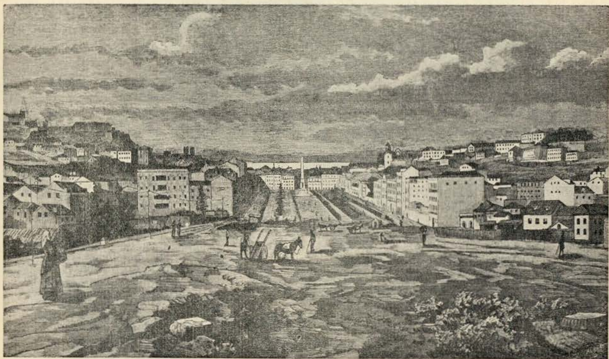
Vista da Avenida da Liberdade e construção da Praça Marquês de Pombal
