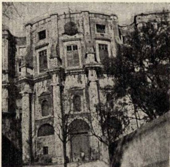
FACHADA PRINCIPAL DA IGREJA DE SANTA ENGRÁCIA (Corpo central)
