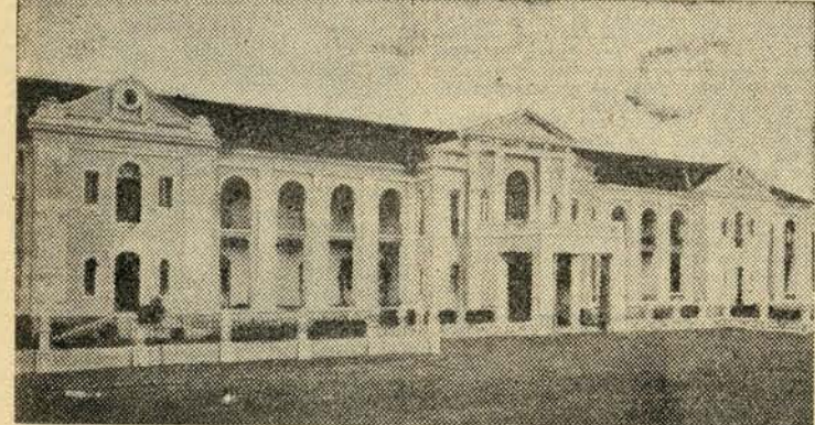
Hospital de Maternidade na cidade de Goa
