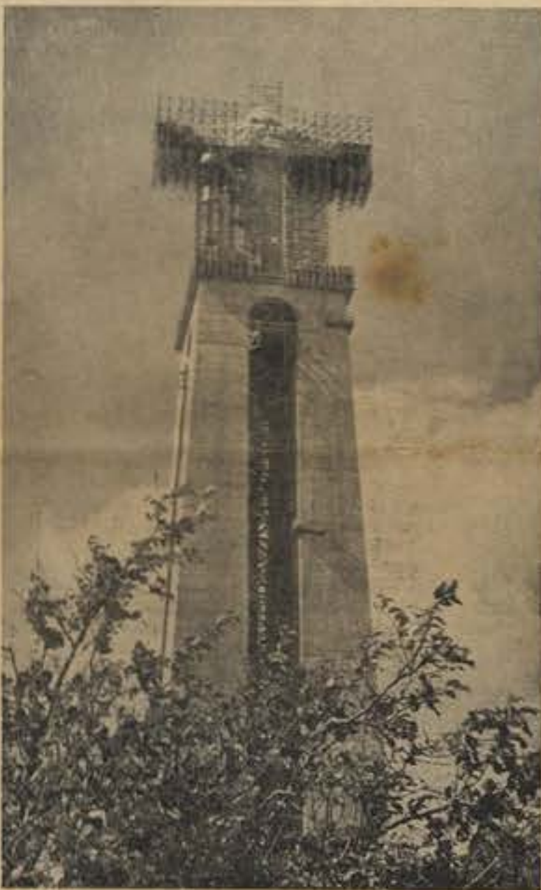
A estátua vista do Sul entre os andaimes.
