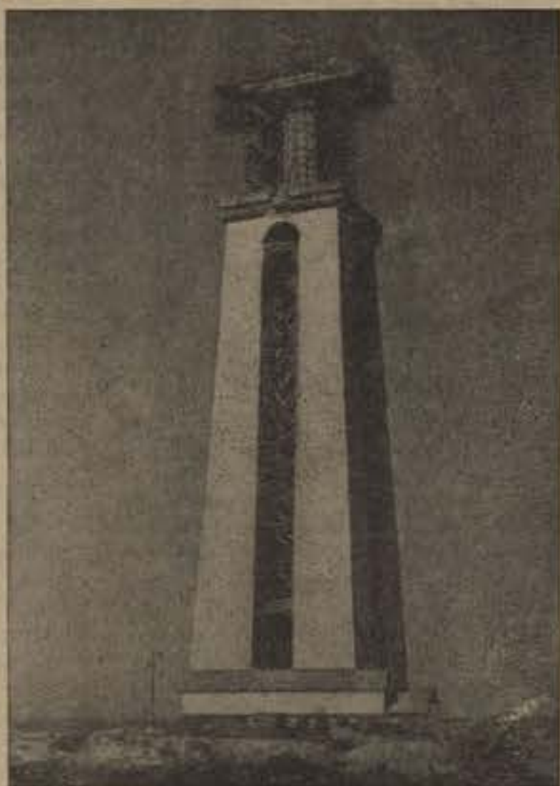
Construção da imagem na altura dos braços
