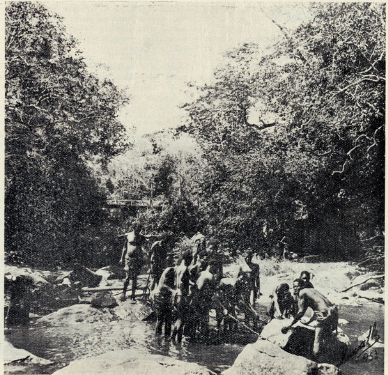
Trabalhos para a construção de uma ponte sobre o Rio Molhelha
