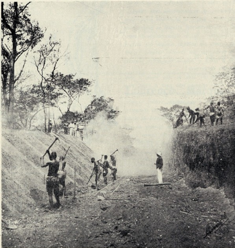
Uma fase da construção
