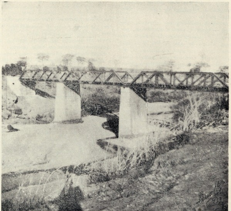
Ponte sobre o Rio Monapo
