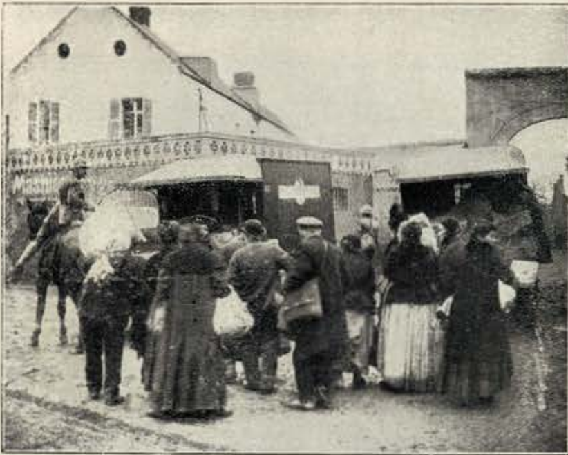
Habitantes de Noyelles sob a proteção dos ingleses sendo removidos da linha de fogo
