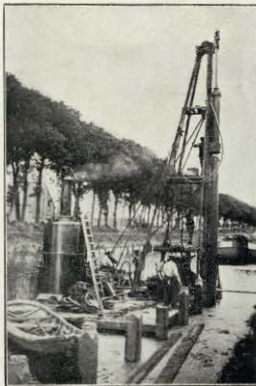
Construção de uma doca, num canal no "front" britânico
