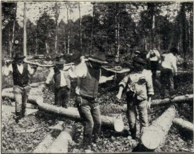
Os portugueses trabalhando na Inglaterra. Carregando madeira.
