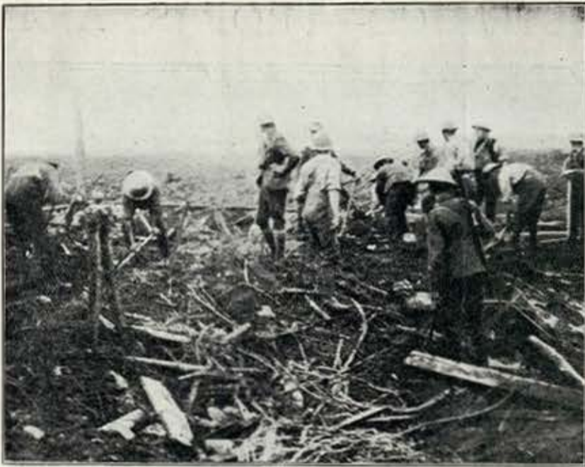
Construção de uma estrada num terreno tomado pelos britannicos
