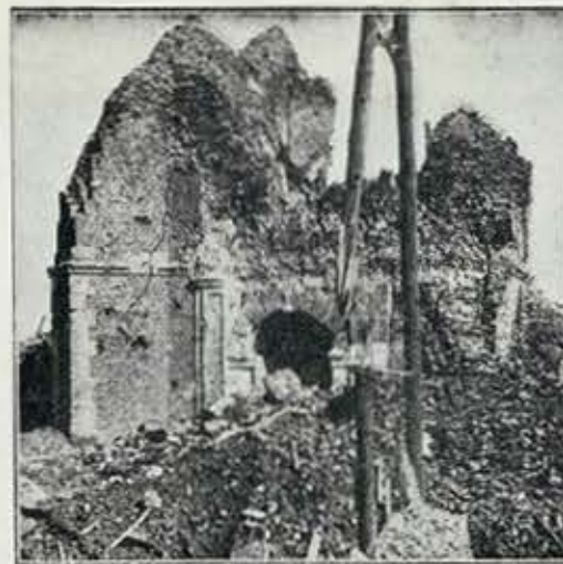
No "front" occidental britânico. Ruínas de uma igreja em Irlas que os "boches" deliberadamente destruíram antes da retirada
