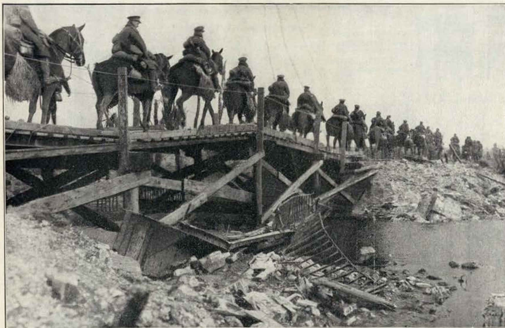
Os allemães, obrigados á retirada, destroem todas as pontes, mas as tropas britannicas rapidamente as constroem
