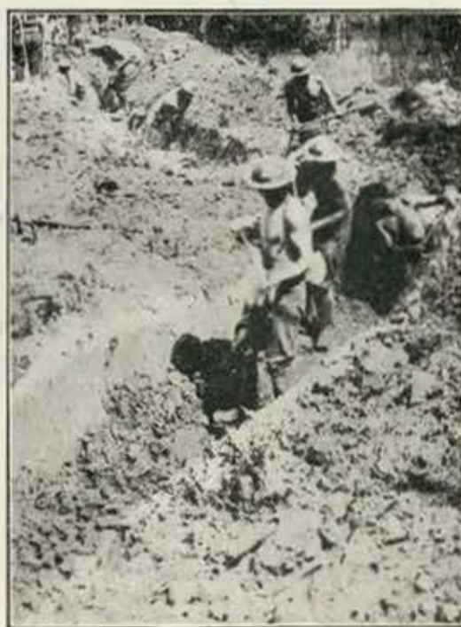
Sapadores abrindo trincheiras de communicão proximo a Messines
