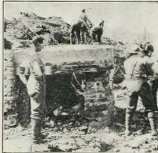
Soldados britannicos demolindo uma fortificação allemã na França
