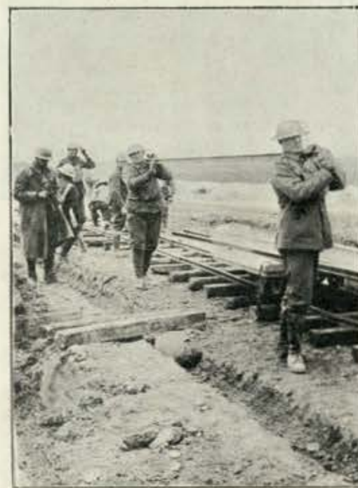
Construindo um estrada de ferro nas proximidades dos trincheiras britannicas.
