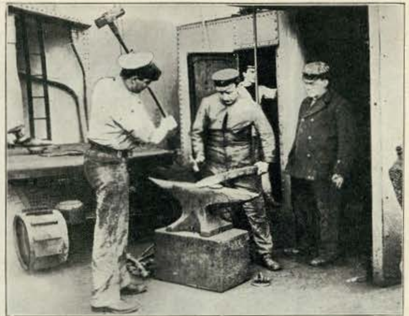
Ferreiros a bordo de um couraçado britannico reparando uma peça das caldeiras
