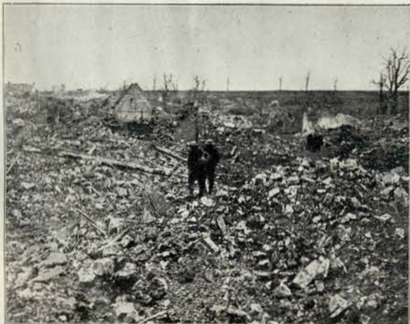
Um desolador aspecto de ruínas numa posição que os allemães foram obrigados a abandonar
