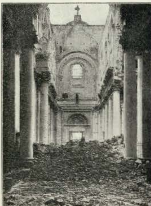
Interior da cathedral de Arras arruinada pelo artilharia allemã.
