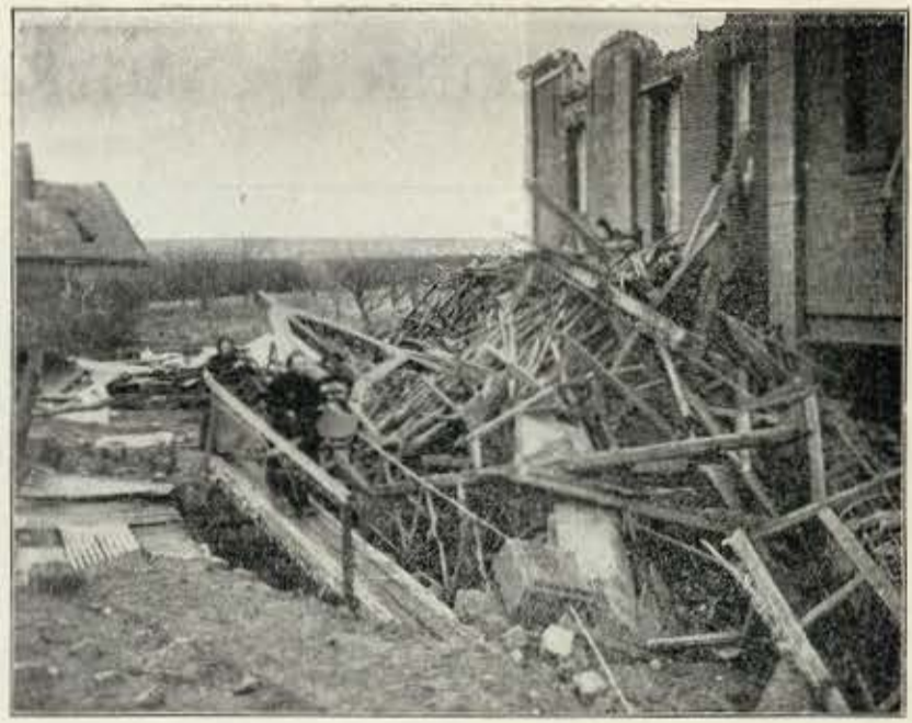
Uma outra prova de barbaria. O estado em que os allemães deixaram uma ponte num canal de Nesle
