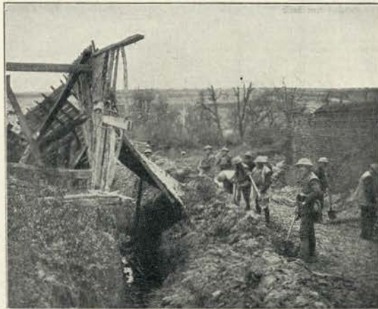
Na vanguarda occidental. Casa bombardeada desabando sobre uma trincheira
