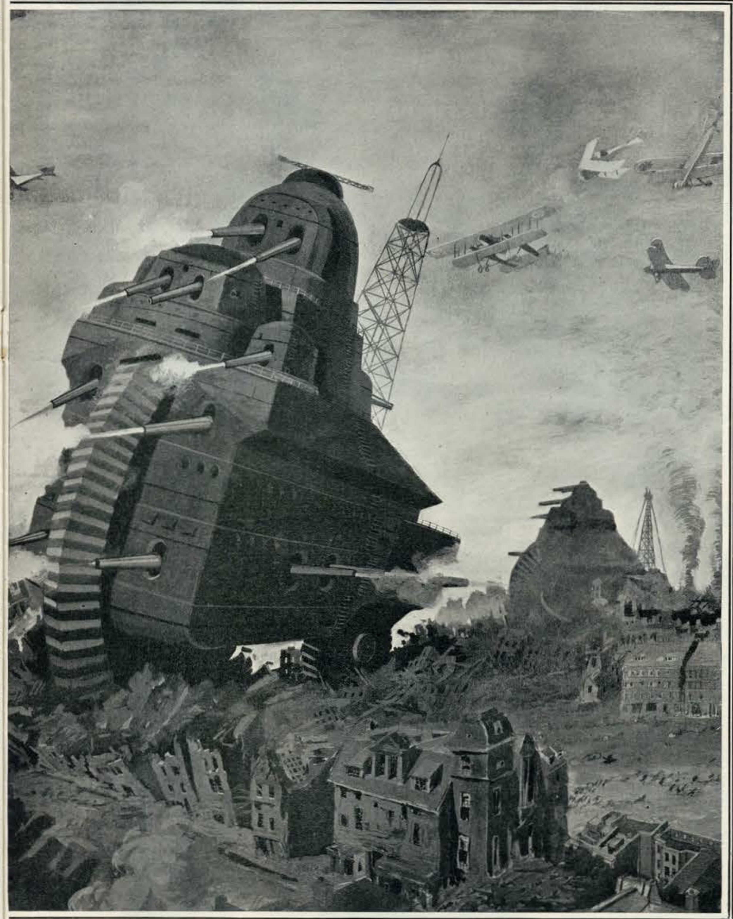
LOCOMOVEL DE TRINCHEIRA E UM CRUZADOR-ELECTRICO RODANTE
