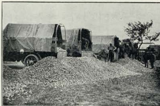
Caminhões descarregando pedrã britada para a construção de estradas nos terrenos conquistados pelos ingleses no grande avanço.
