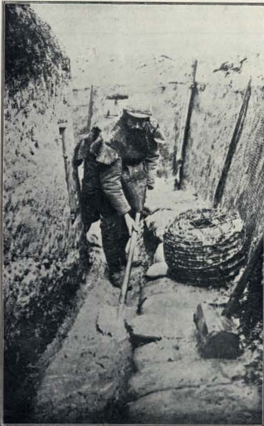
Desapiedando uma trincheira franceza na primeira linha de combate depois de torrencial chuva
