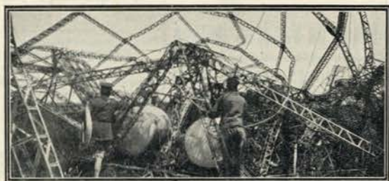
Os depositos e armação do zeppelin destruido pela artilharia ingleza.
