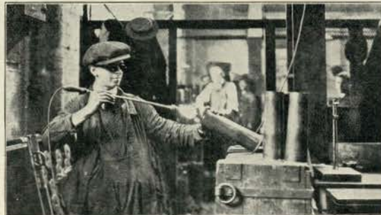
Examinando o interior de um obuz para lhe localisar os defeitos.
