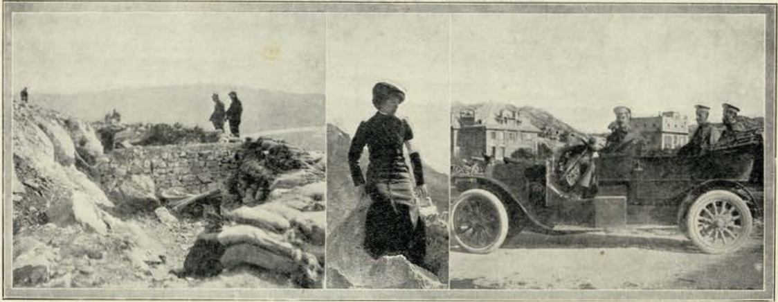
Uma secção de trincheiras no Montenegro.
