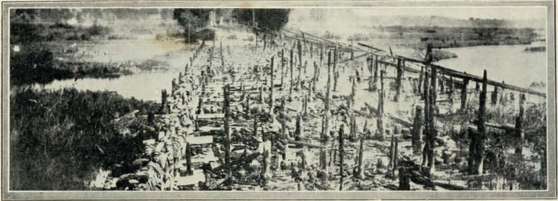
Tropas alemãs atravessando uma ponte construída para substituir a que os servios queimaram no seu heroico recuo.
