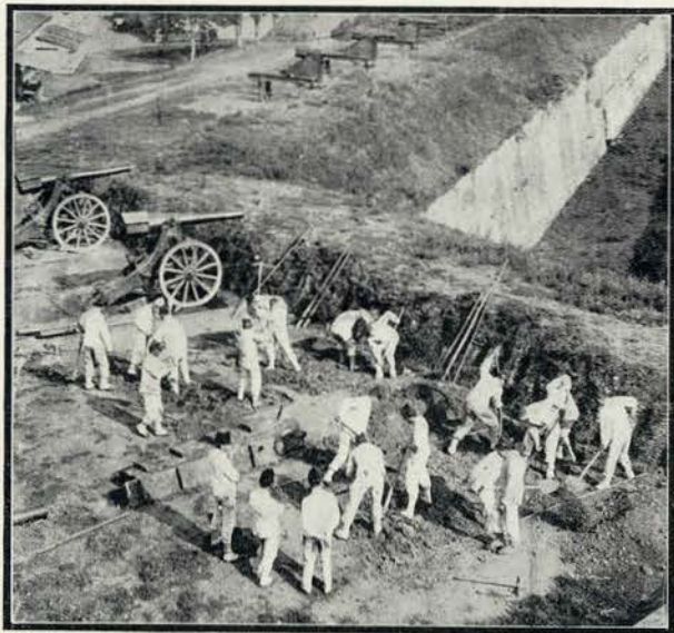
Uma interessante scena na fronteira austriaca. Os engenheiros italianos, dispondo em posição os seus excellentes canhões, preparam bases de concreto para os assentar.
