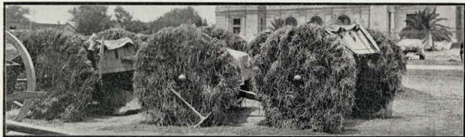
O sol fortissimo prejudica a artilharia entortando as rodas, por isso, algumas peças são engenhosamente protegidas com palha, como mostra a photographia.
