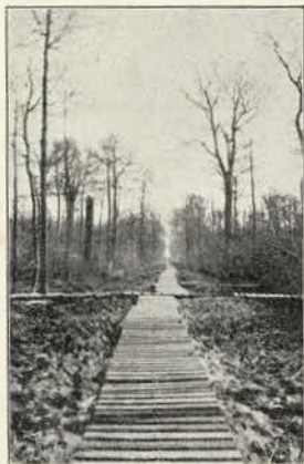
Avenidas de madeira, construí das pelos soldados britannicos, para evitar o inconveniente da lama.
