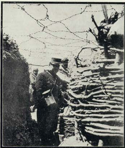
Uma trincheira em Argonne, mostrando o arame farpado de maneira a defender a posição, de ataques noturnos.
