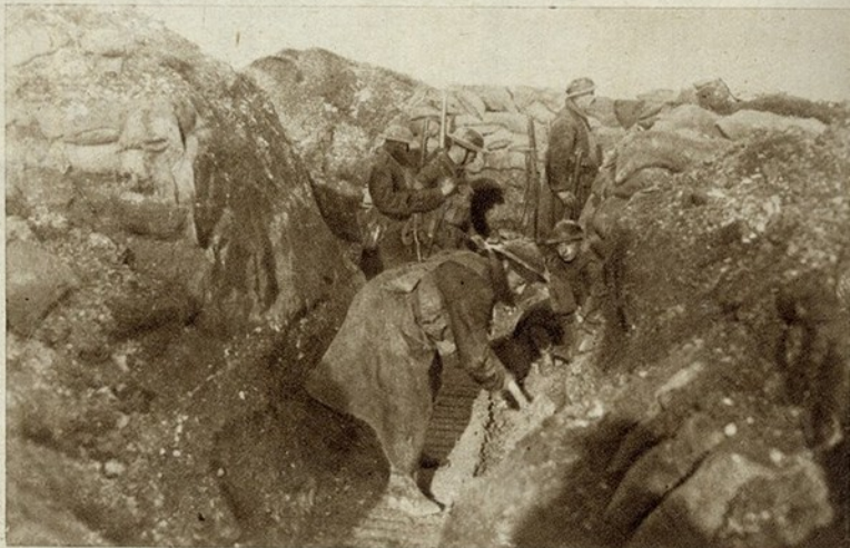
Na frente da 62.ª Divisão, em Janeiro de 1918, soldados do Regimento de York e Lancaster reparam um parapeto
