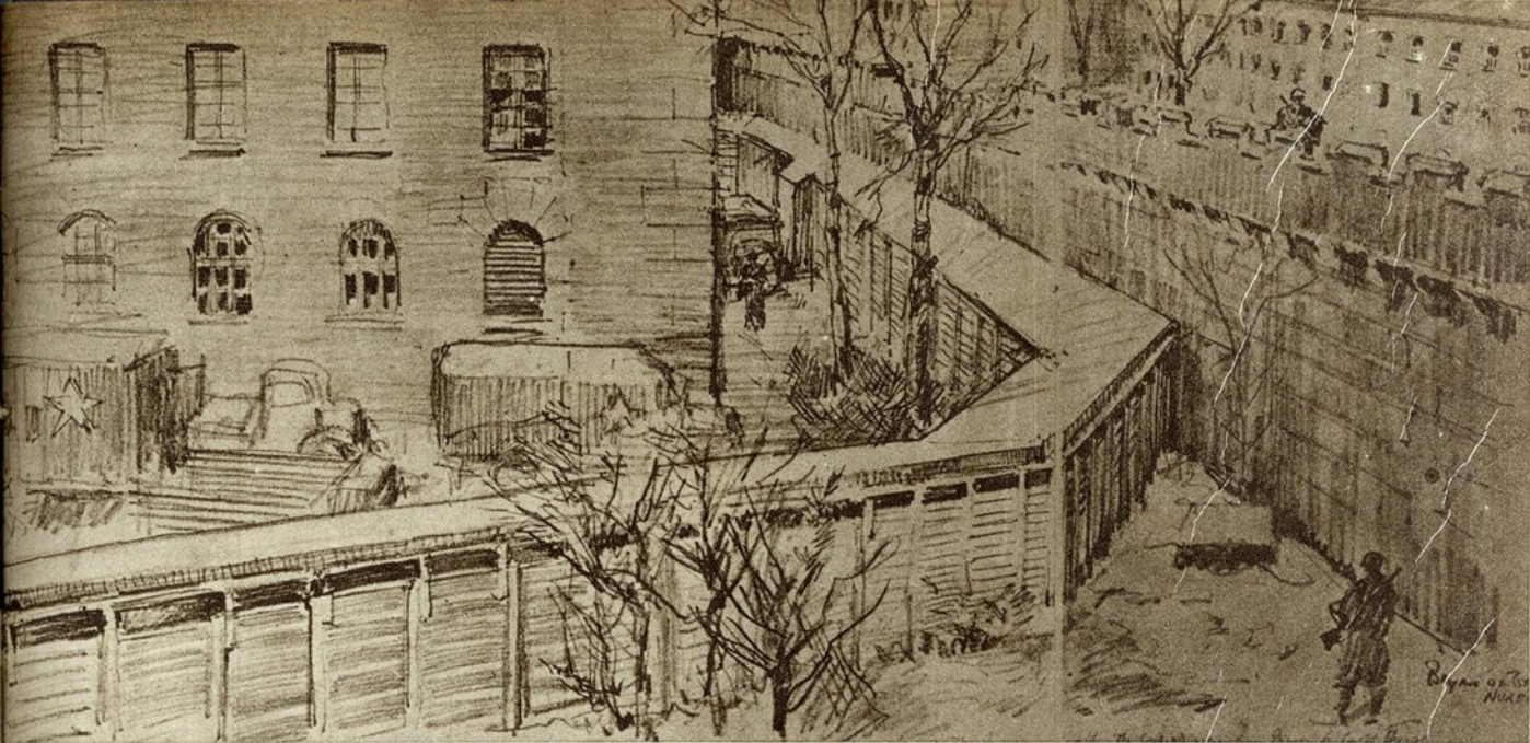
Como rigorosa medida de segurança, foi construído um túnel entre o corpo da cadeia, onde se encontram as celas e as sala de audiência. Assim a fuga não é possível
