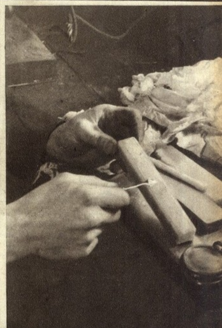
Afia-se a ponta de um instrumento para operações dos olhos
