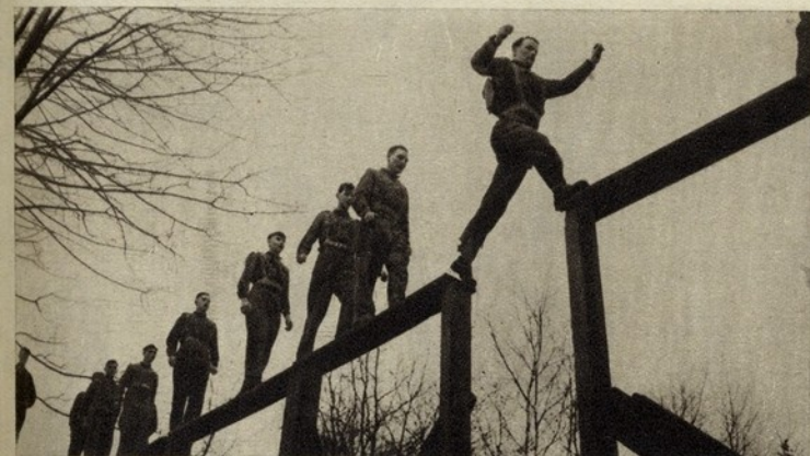
Exercício de sangue frio e de equilíbrio. A ponte tem 7,50 metros de altura e falta lhe o lanço central
