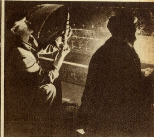
Arranjando o arco da roda. Brocam-se novos furos
