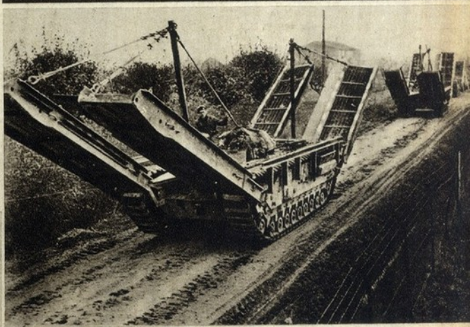
Este é outro sistema para vencer tôda a espécie de obstáculos: a ponte Ark. Examinando a fotografia é fácil compreender o seu curioso funcionamento. O próprio, tank suporte serve de passagem
