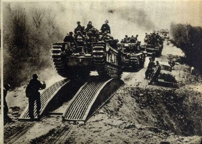
Este é outro sistema para vencer tôda a espécie de obstáculos: a ponte Ark. Examinando a fotografia é fácil compreender o seu curioso funcionamento. O próprio, tank suporte serve de passagem
