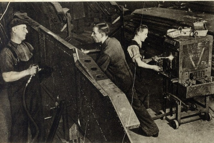
A cravação das blindagens dos tanks, uma das primeiras fases da construção em série das máquinas de guerra que, mais directamente, contribuíram para a vitória
