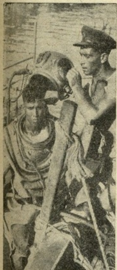
Novos engenheiros ingleses trabalham na construção de modernos portos fluviais, na Birmania, utilizando escafandros
