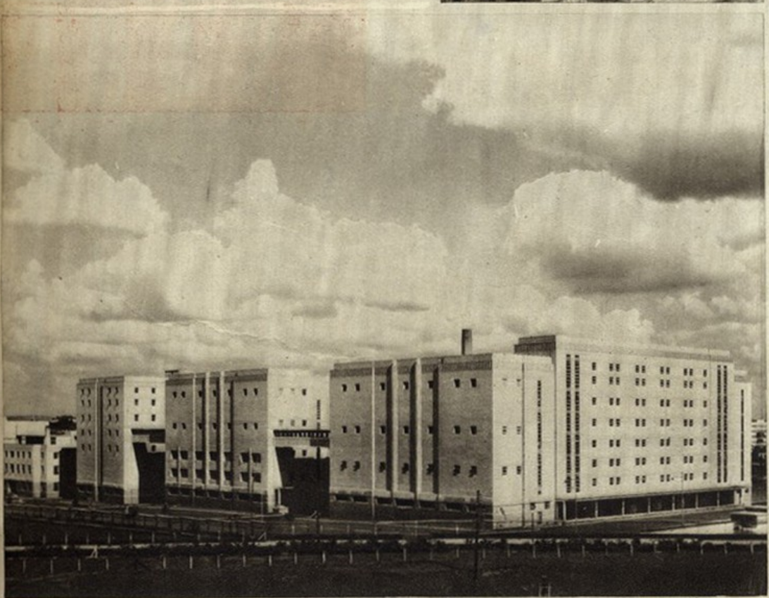
A moderna arquitectura inglesa da fábrica de Guinness, construída segundo os traços de sir Gilbert Scott, de estrutura rigidamente utilitária. Por menos curioso: as pequenas janelas foram exigidas pelo cliente, ao contrário dos grandes envidraçados que se vêem nos grandes edificios fabris modernos
