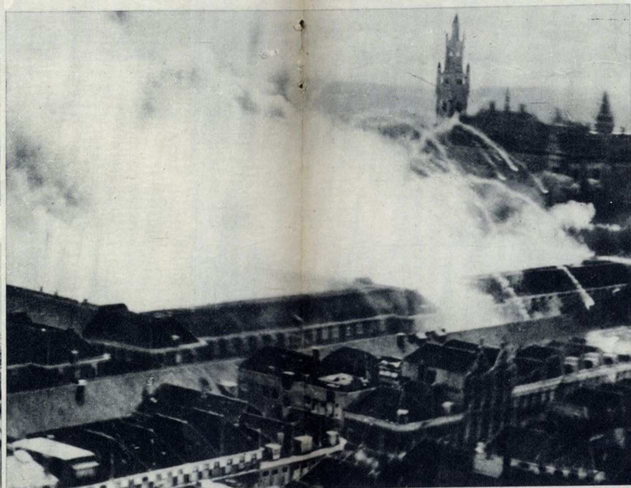
Uma façanha dos «Mesquitos». Por comunicações secretas da Holanda, soube-se que na cidade de Scheveningach os alemães guardavam, neste edifício, numerosa documentação de guerra referente às operações. Os aparelhos voaram até lá e, com notável precisão, incendiaram o edifício, destruindo por completo os arquivos nazis
