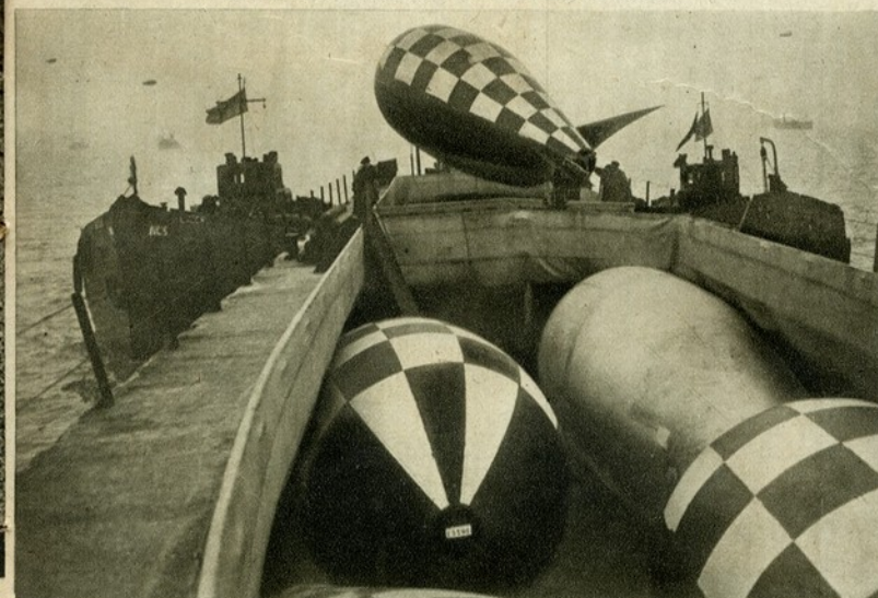
Estes aerostatos protegem os navios e acompanham-nos toda a travessia, amarrados por cabos de aço ao convés
