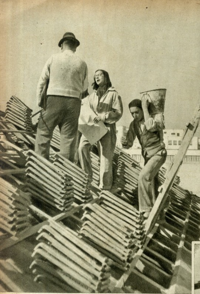
As mulheres já intervêm na construção de prédios. A sr. a D. Celeste Ribeiro no telhado de um edifício em construção, dando instruções a um mestre de obras
