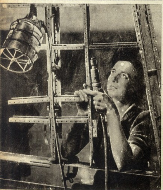
A mulher também trabalha nas oficinas. Abrindo os furos para a rebitagem de uma armadura metálica.
